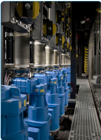
Separate Achsantriebe für Prospektzüge mit stehenden Seiltrommeln auf dem Schnürboden ca. sechs Meter über Bühnenniveau.
