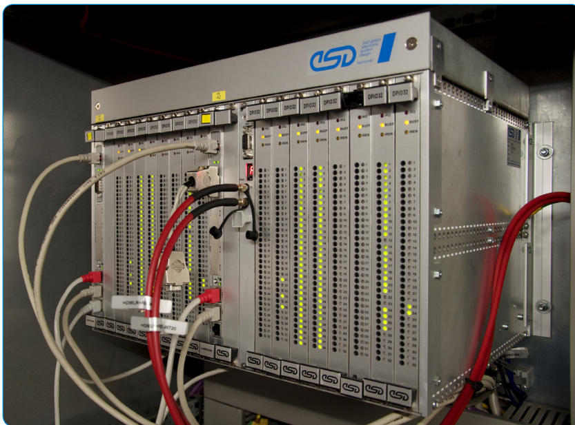
Gedoppelter Leitreehner mit zwei VMEbus-CPU-Karten MVME 5100 von esd.
